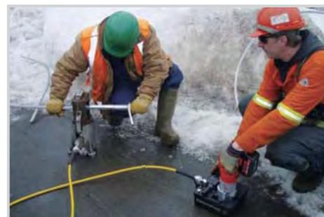
電気もエアも供給できない作業現場で、バッテリー式電動油圧ポンプが有効です。
