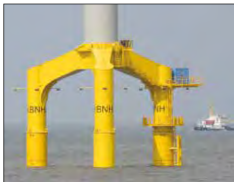
▲ 海上風車タワーレベリング作業: Enerpacは同調ポンプシステムで80本の海上風車タワーのレベリング作業を行いました。
